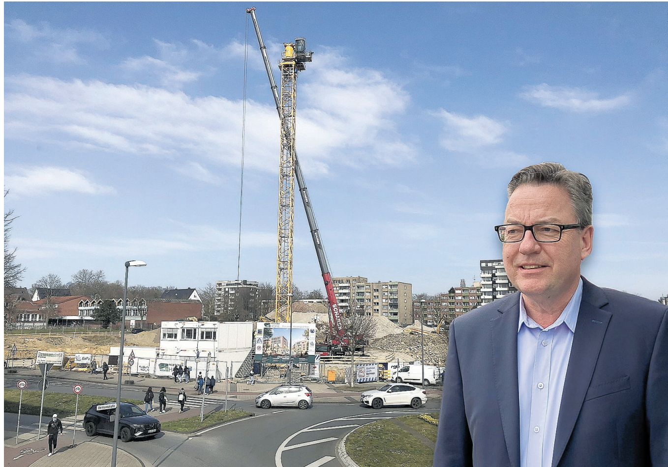
Auf der Großbaustelle der Hertener Höfe ist ordentlich Bewegung: Dr. Stephan Schnitzler von Phoenix Development kündigt für April den Rohbau-Start an.
